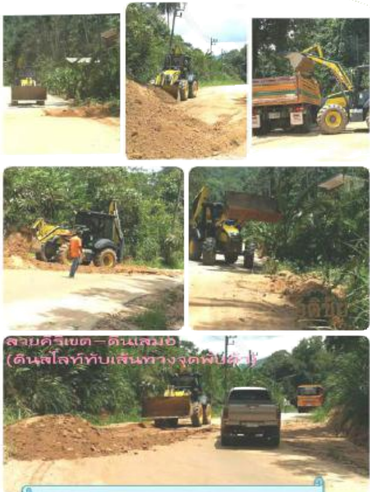
โครงการปรับปรุง/ซ่อมแซมถนน
